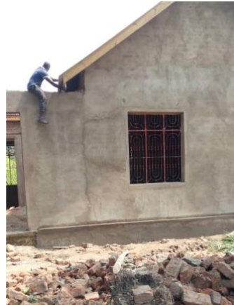
Rückseite des Schulhauses. Wir haben den Bau des Gebäudes finanziert. Die Regierung wird den Innenausbau übernehmen.
